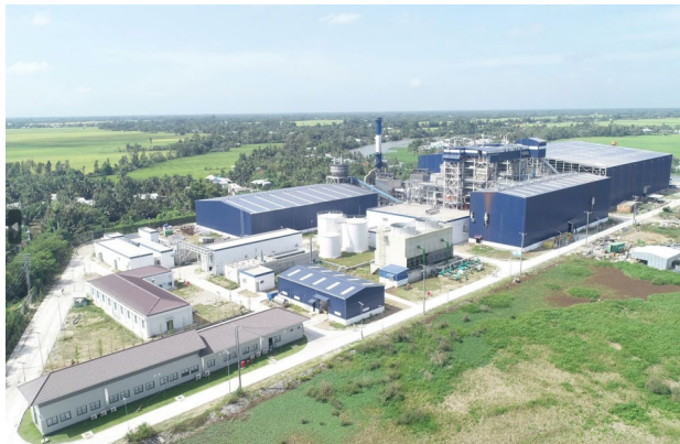
Nhà máy điện sinh khối Hậu Giang
